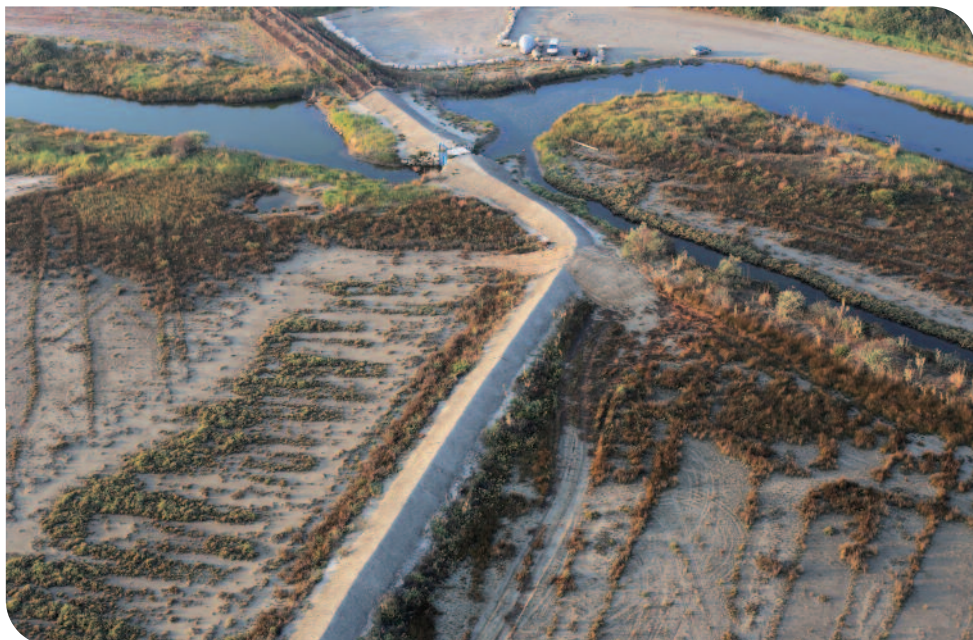
Confortement de talus artificiels existants
