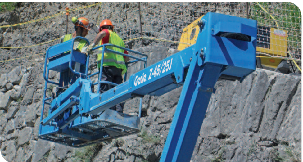
Entretien/rénovation d'un barrage de correction torrentielle en maçonnerie (Riou Bourdoux - 04)
